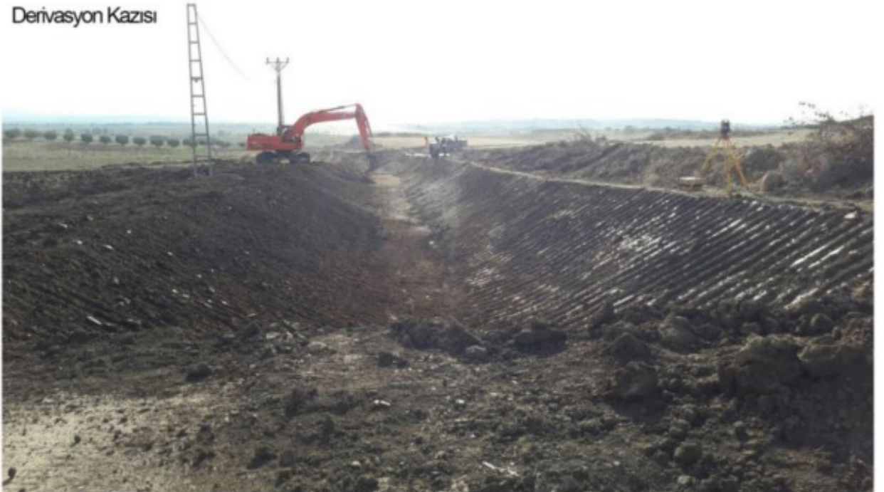
Derivasyon Beton Kaplama
